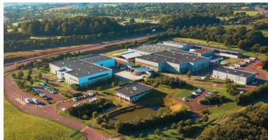
Pôle de valorisation de Cavigny - 2021
