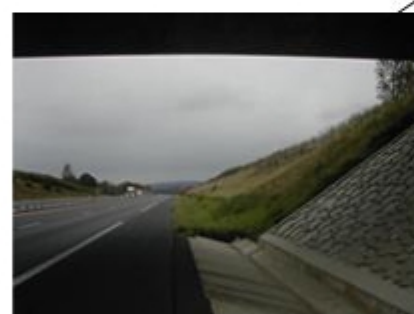
Encaissement de la voie, pas de perceptions.
