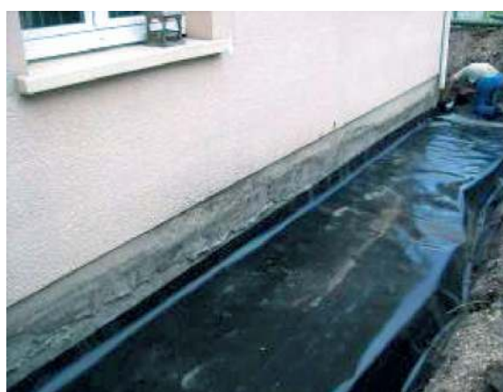
Figure 22 Géomembrane en cours de pose (Source Socabat)
