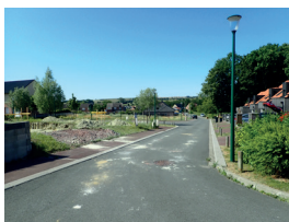
La rue P. Bachelet est une voie tertiaire disposant de trottoirs et d'un éclairage public
