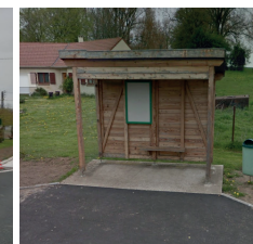
L'arrêt de bus implanté près de la zone.
