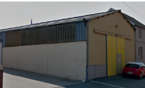
Exemple de bâti économique proche de la zone. Les couleurs sont variées et la tôle domine. La hauteur est d'environ 6m.
