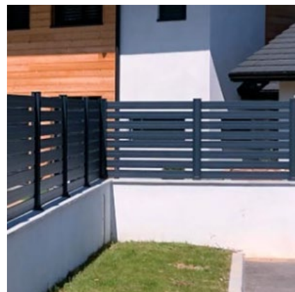
Mur surmonté d'un dispositif à claire-voie
