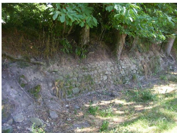
Figure 19. – Haie trois strates sur talus mur. Photo : Philippe BOULVRAIS, 2013.
