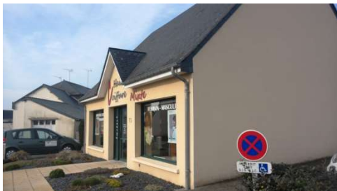
Dépasse l'égout du toit
