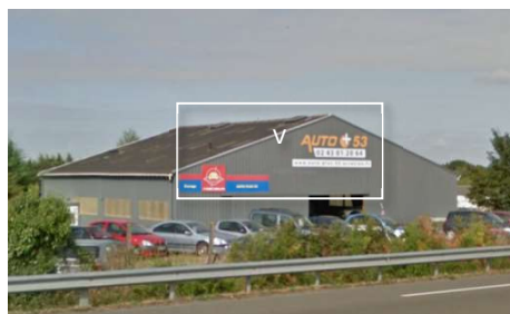
Dépasse l'égout du toit
