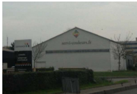
Dépasse l'égout du toit
