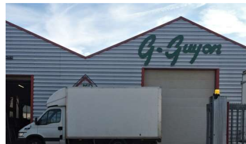
Dépasse la limite de l'égout du toit
