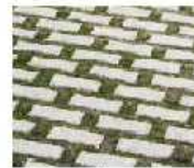
Pavage en béton avec ouvertures de drainage
