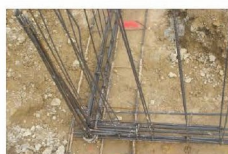
Nœud de chaînage - Continuité mécanique
