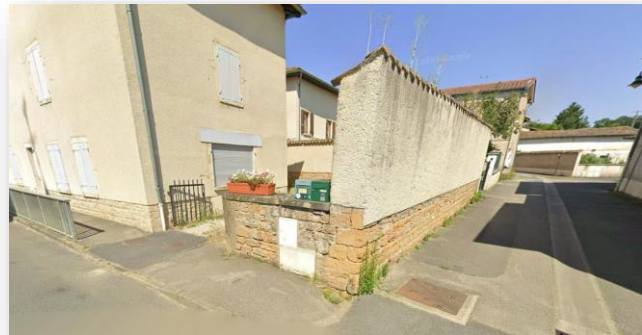
Les soubassements en pierre sont laissés apparents
