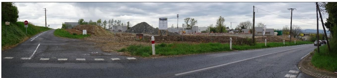
Intersection entre le chemin du Plumeret et la RD 904 avec l'espace en construction (avril 2025)
