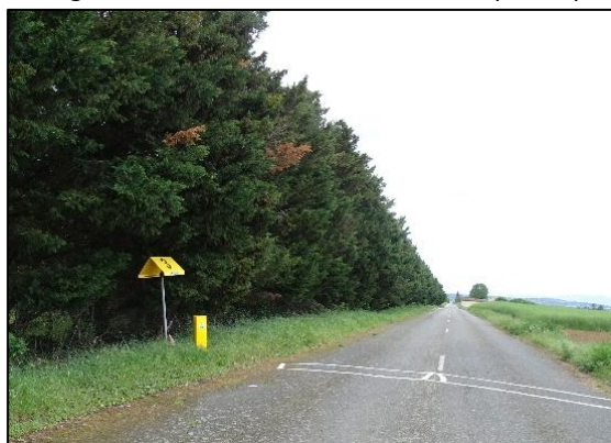
Borne de signalisation de la canalisation de gaz
