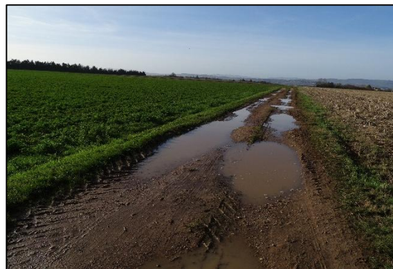
Accumulation d'eau sur un chemin agricole vers les Seyettes
