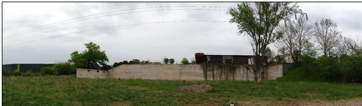
Vue sur la zone d'activités du Pardy à l'Est et le mur de soutènement depuis le site
