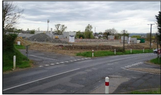
Extension de la zone d'activités avec la construction d'un supermarché (avril 2025)
