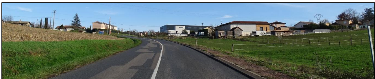
Perception de la promiscuité entre les habitations du Bois de Ternand et la zone du Pardy le long de la RD 904
