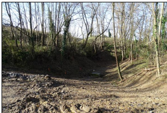
Ouvrage hydraulique en construction près du chemin de la Borne au Nord-Ouest du bourg
