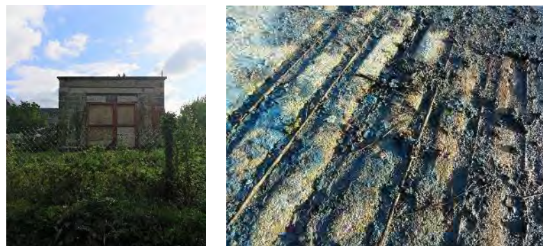
Vestige de la Base de lancement Ecaquelon / piste bétonnée à Triqueville
