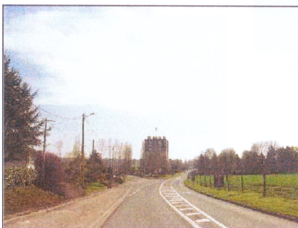
Entrée n°7 : en venant de Ligny-sur-Canche par la RD941
