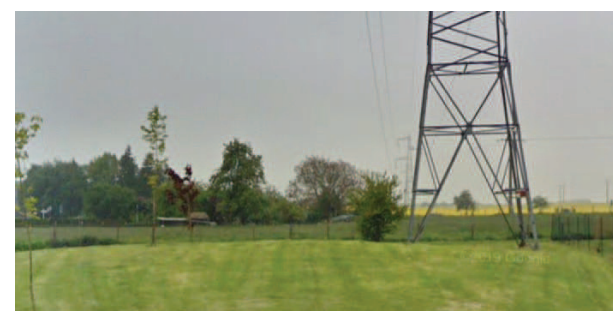
Vue sur la ligne électrique haute tension depuis la Résidence du Clos Frominel
