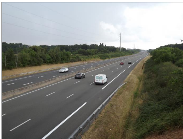
A11 à Illiers-Combray
