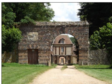
Château de la Rivière à Pontgouin
