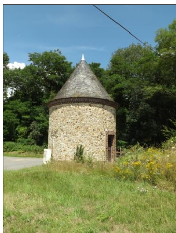
Tourelle à Pontgouin
