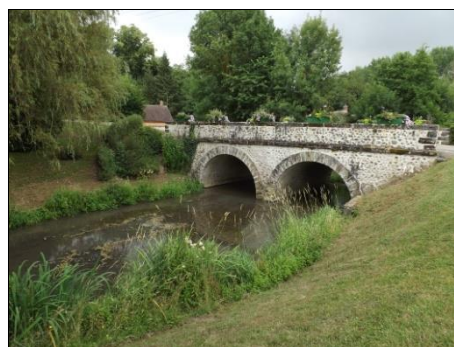
Pont sur la Thironne à Montigny-le-Chartif
