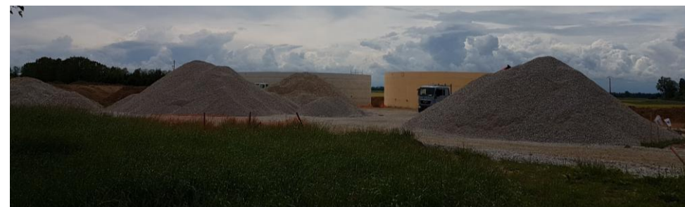
Figure 92 : chantier de l'unité de méthanisation
