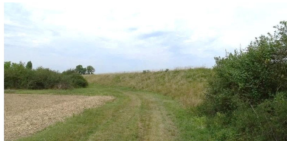
Figure 94 : Digue de Petit-Noir
