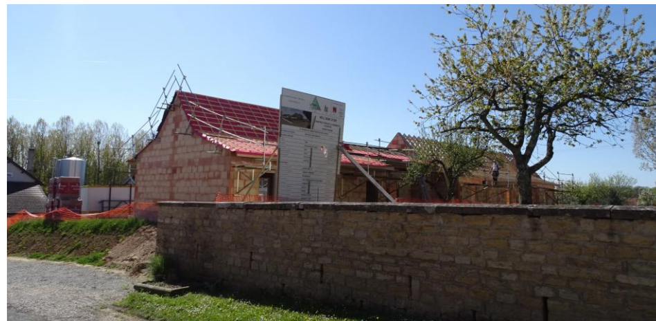
Figure 196: Construction de logement locatif à Pleure
