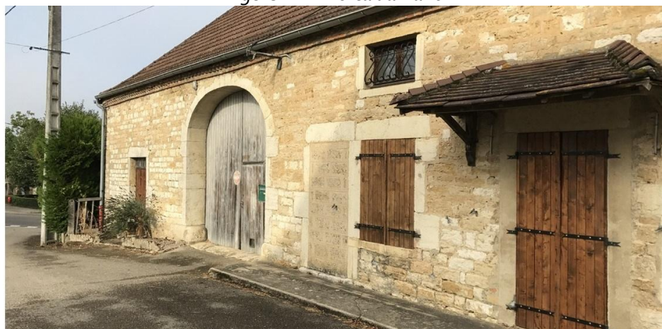
Figure 167 : Porte de grange à Asnans-Beauvoisin
