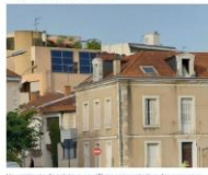
Un exemple de forme nouvelle : alignement des panneaux non adaptés. © Roland Pelletier
