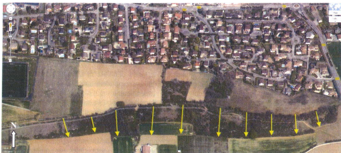
Figure 11 : vue aérienne oblique du secteur de Côte Bernard (les flèches jaunes matérialisent la zone à plus forte pente du secteur)
