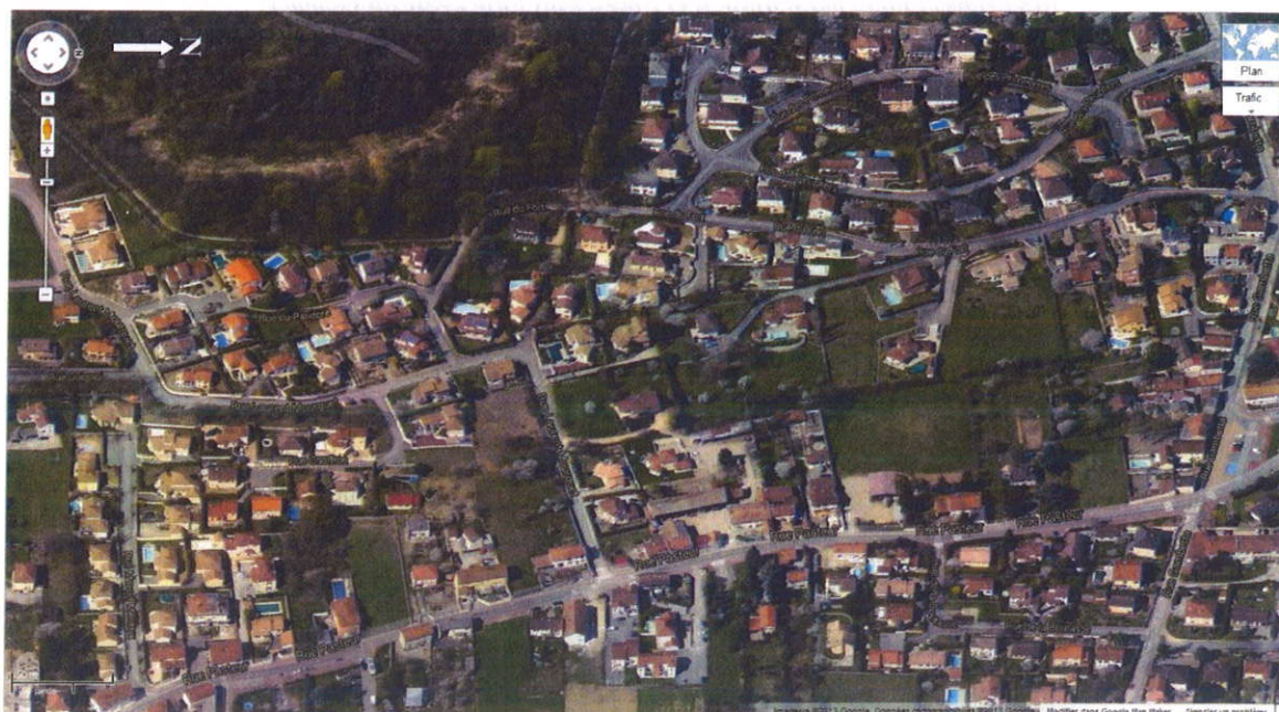
Figure 14 : vue aérienne oblique du secteur de Montsec
