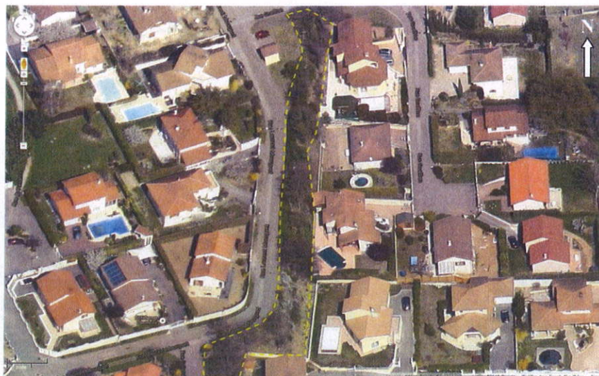
Figure 16 : talus aval de la rue Mourguet
