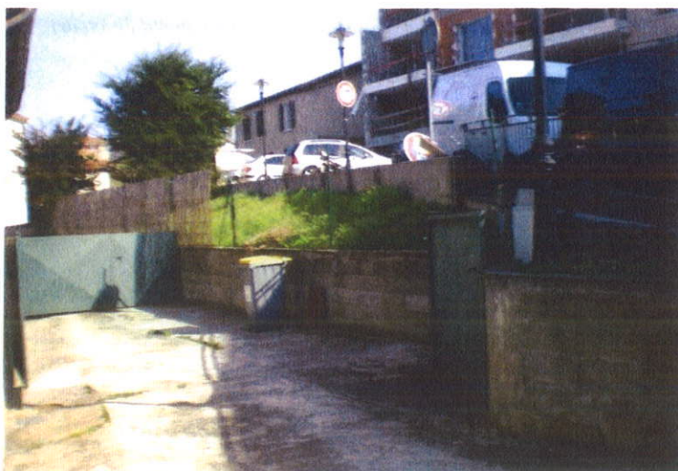
Figure 7: mur en parpaings dans le talus aval de la rue de la Liberté
