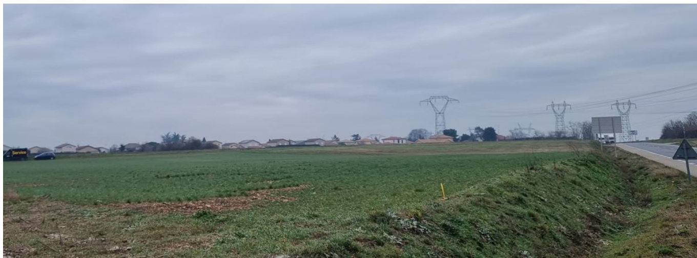
Figure 32 - Lignes à haute tension passant au dessus du secteur classé Ne au PLU actuel
