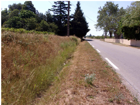
Caniveau étanche à mettre en place en bordure de la Route départementale n°13 (Le puits de La Fontaine est à droite sur la photographie)
