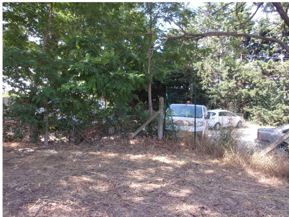
Clôture du Périmètre de Protection Immédiate à réhabiliter secteur Sud
