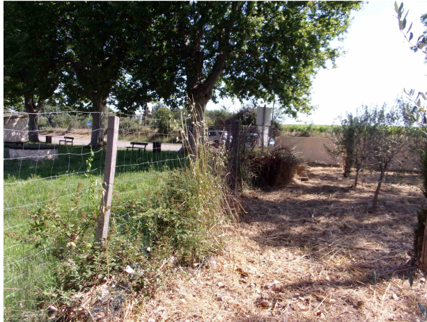
Clôture du Périmètre de Protection Immédiate à réhabiliter secteur Nord
