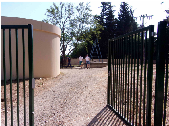
Portail existant du Périmètre de Protection Immédiate du puits de La Fontaine à conserver
