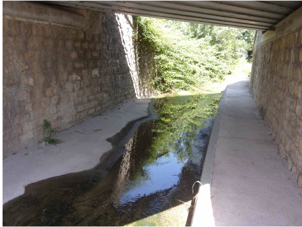
Ruisseau alimenté par des eaux usées
