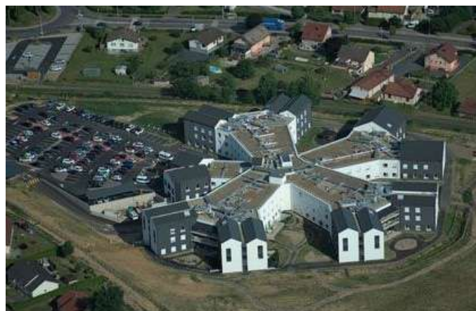
Centre hospitalier des cinq vallées
