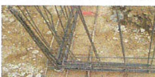
Noeud de chaînage - Continuité mécanique
