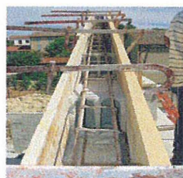
Mise en place d'un chaînage au niveau du rampant d'un bâtiment
