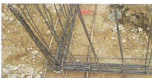
Nœud de chaînage - Continuité mécanique
