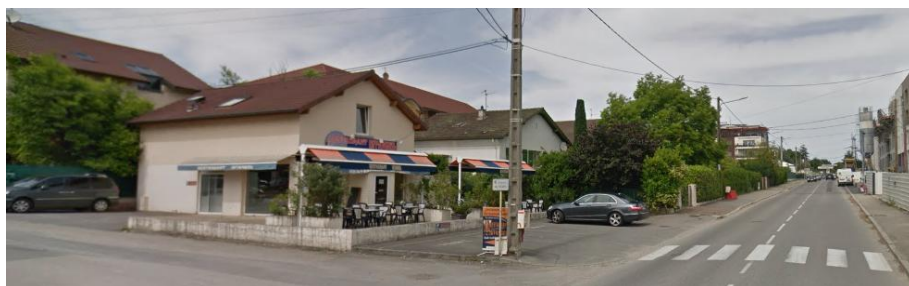
Localisation de l'OAP Chemin des Fleurs - Vues depuis la rue de Versoix
