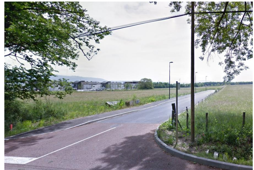
L'entrée du site depuis le carrefour de la rue du Lac Parc avec la route de Mategnin
