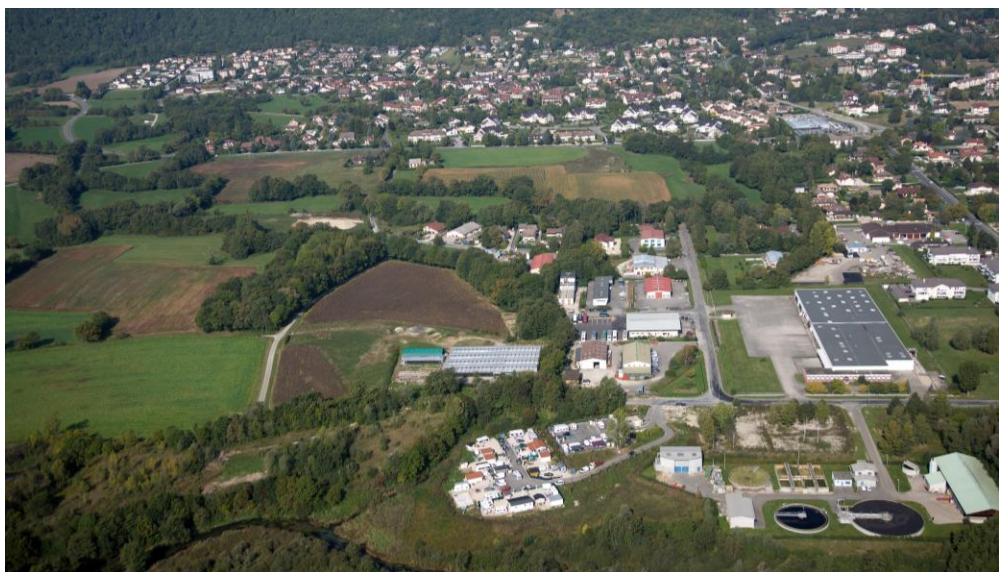
Vue du site (photo de 2011)
