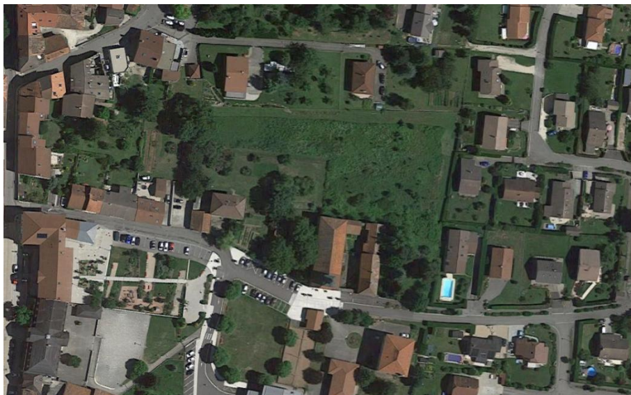
Localisation de l'OAP Château / Vue aérienne
