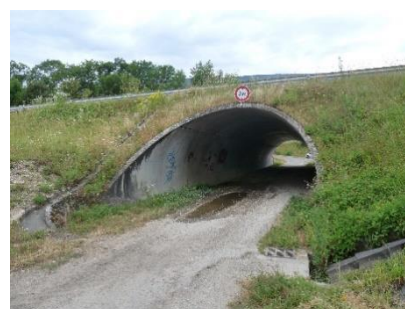
Ouvrage inférieur avec bande enherbée
