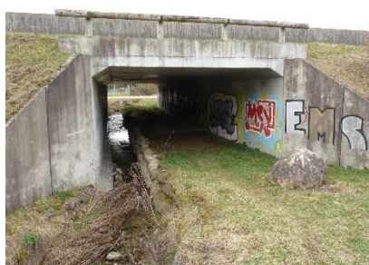
Ouvrage mixte avec banquette semi-végétalisée
