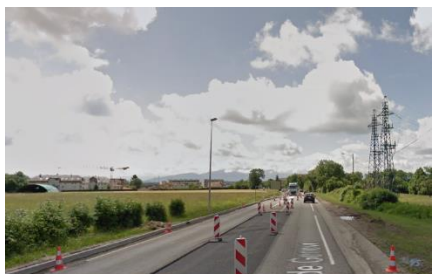
Voie existante, RD1005
