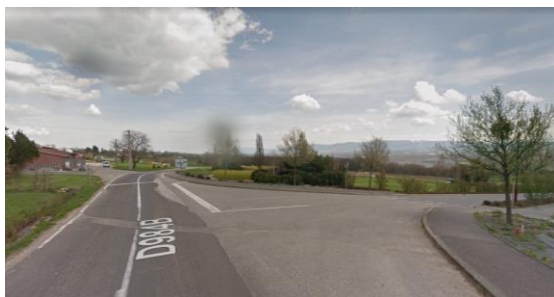
RD984B à son intersection avec la rue du Rhône
