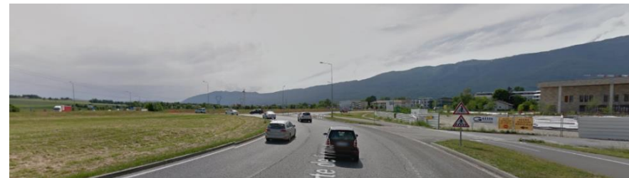
Entrée de ville à l'Est du secteur : rond-point Porte de France
