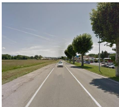
Rue de la Faucille et traitement paysager le long des cellules commerciales
