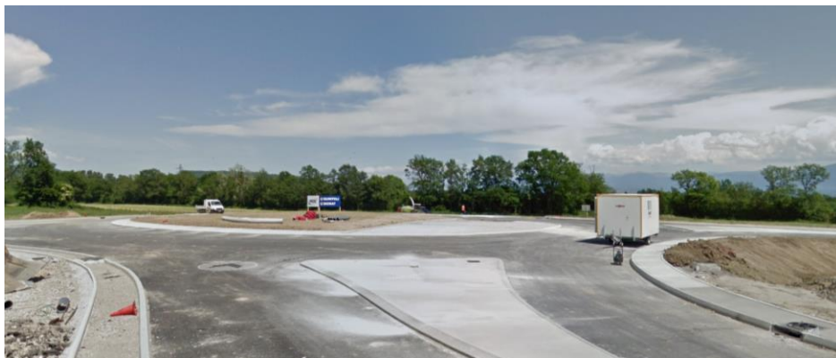
Rond-point en cours de construction en mai 2018
