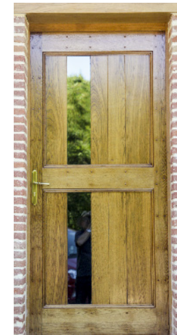
La menuiserie en bois s'adapte aux baies d'origine (épouse les angles, aspérités ou décalages de la baie ancienne) Elle est garante d'une cohérence fonctionnelle et esthétique avec le bâti ancien.
