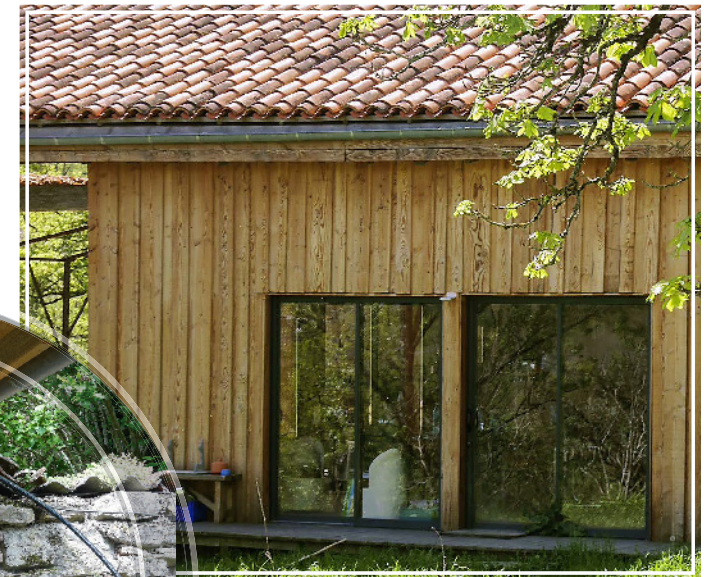
Un bardage bois posé verticalement permet de donner un certain relief à la façade.
