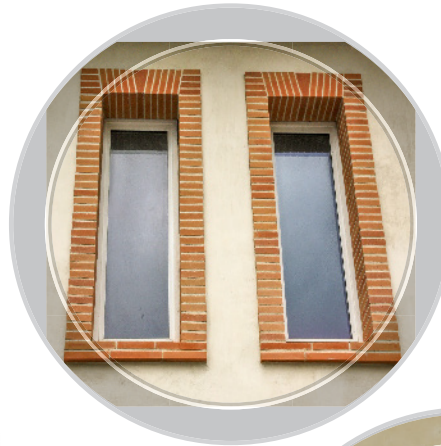
La menuiserie aluminium ou acier laqué offre des qualités de durabilité et de facilité d'entretien. Ces menuiseries sont parfaitement adaptées aux sites très exposés aux intempéries. Leur section est faible, ce qui est un atout pour la qualité de l'éclaircement. La gamme des couleurs proposée est assez large.
