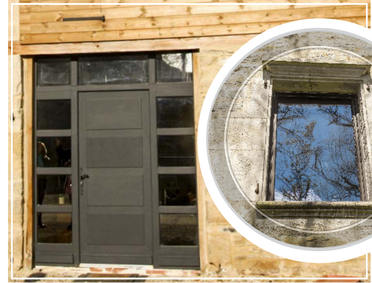
La menuiserie aluminium ou acier laqué offre des qualités de durabilité et de facilité d'entretien. Ces menuiseries sont parfaitement adaptées aux sites très exposés aux intempéries. Leur section est faible, ce qui est un atout pour la qualité de l'éclaircement. La gamme des couleurs proposée est assez large.
