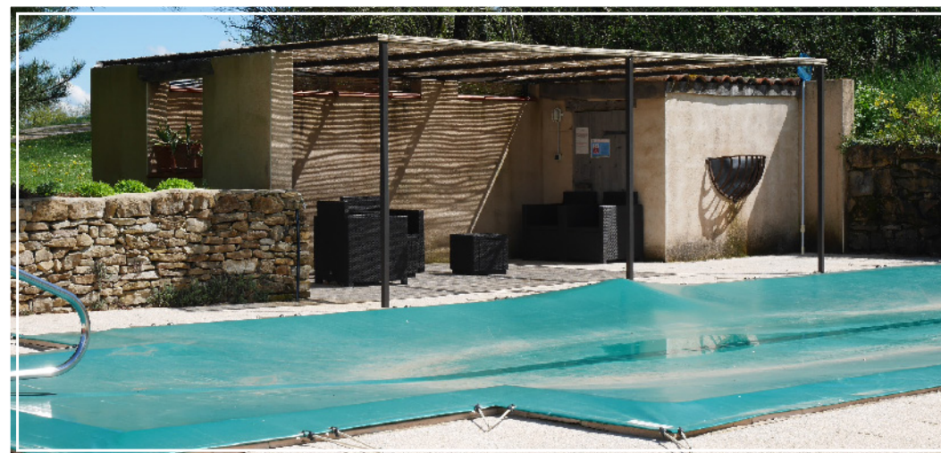
Le pool-house est intégré au muret existant et l'enduit beige rosé s'insère parfaitement avec les matériaux environnants (dalle piscine, gravier).
