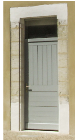
La menuiserie en bois s'adapte aux baies d'origine (épouse les angles, aspérités ou décalages de la baie ancienne) Elle est garante d'une cohérence fonctionnelle et esthétique avec le bâti ancien.
