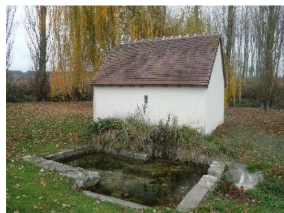
3. Buxeuil : chapelle-Saint-Martin et fontaine
