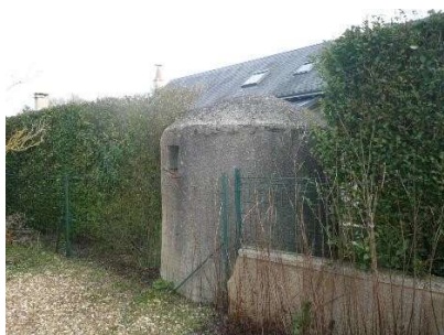
25. Meunet-sur-Vatan : puits de Vornault
