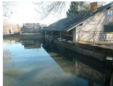
33. Vatan : lavoir de la Poterne près du centre historique
