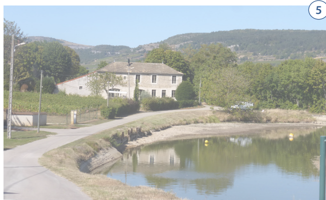
Un aménagement sommaire, voire inexistant, pour une berge "bucolique", à Remigny (Dheune)
