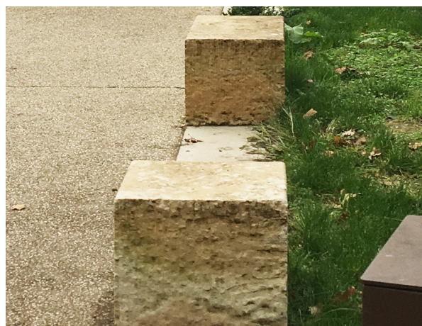
Chalon-sur-Saône - Maison des Vins
