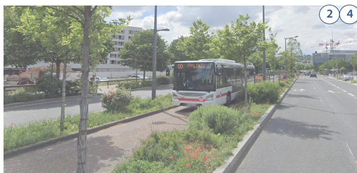
Lyon - Couloir de bus paysager, alignement d'arbres et strate végétale basse
