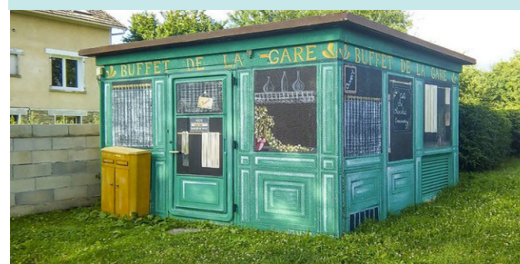
L'intégration des dispositifs de distribution d'énergie (transformateurs)
