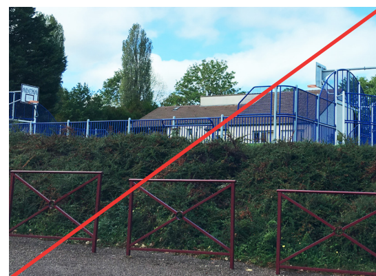
Hétérogénéité des barrières de protection, et couleurs vives, à fort impact visuel (Lux)
