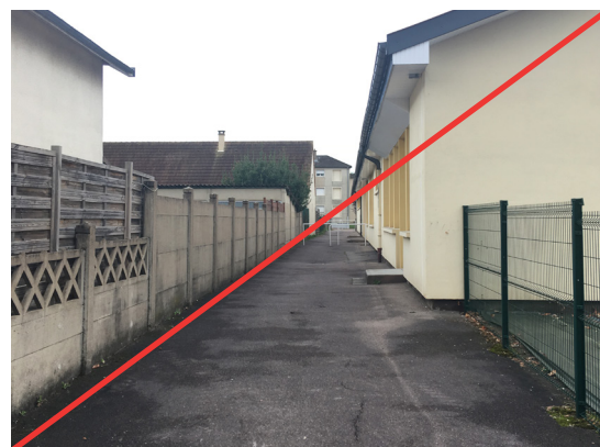
Hétérogénéité des clôtures, treillis soudé (Lux)
