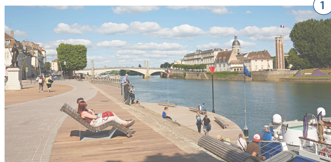
Une estacade sur la Saône pour une halte dans le prolongement de la Place du Port Villiers, à Chalon-sur-Saône
