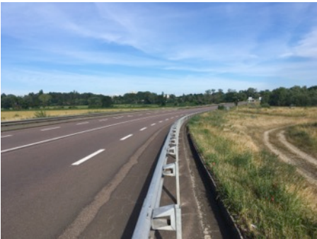
RD906, en allant vers Chalon RD906, à l'approche de la plateforme prévue pour l'aménagement d'un rond-point
