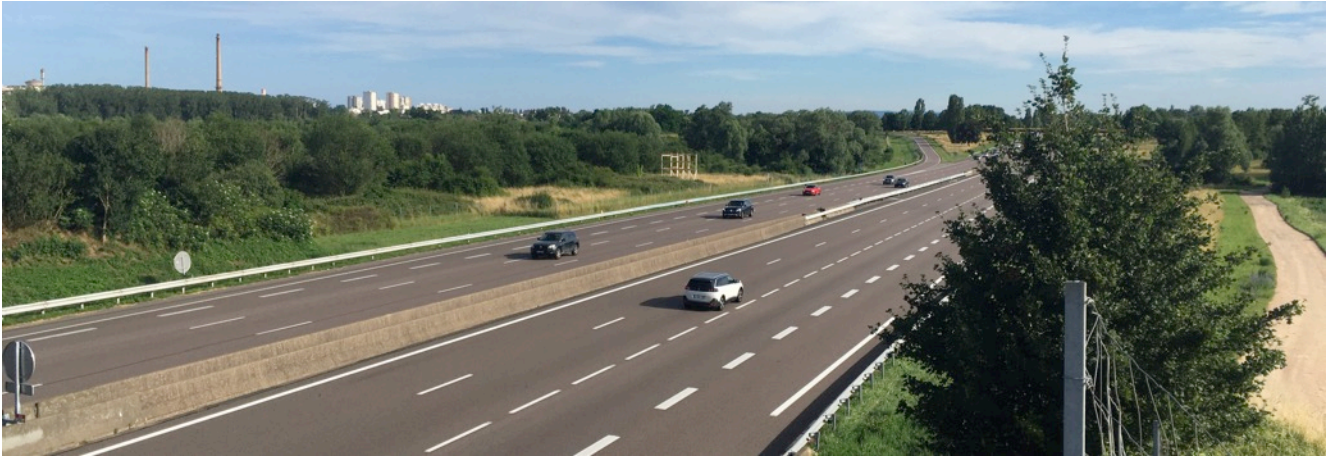
Façade autoroutière du secteur des Moirots depuis le pont de la RD906
