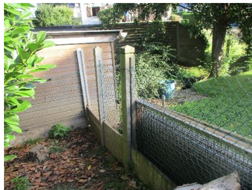
Abri de jardin posé sur le fossé
