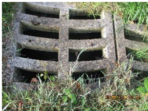
E7 – Bassin rétention 4 Epines
