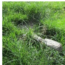
E8 – Bassin rétention 4 Epines
