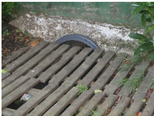
Collecteur en DN 400 posé sous l'abri de jardin
