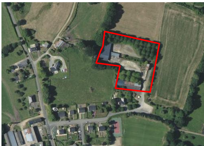
Photo aérienne de l'entreprise de travaux agricole au nord du bourg de Chantrigné et délimitation envisagée ; Source : Géoportail
