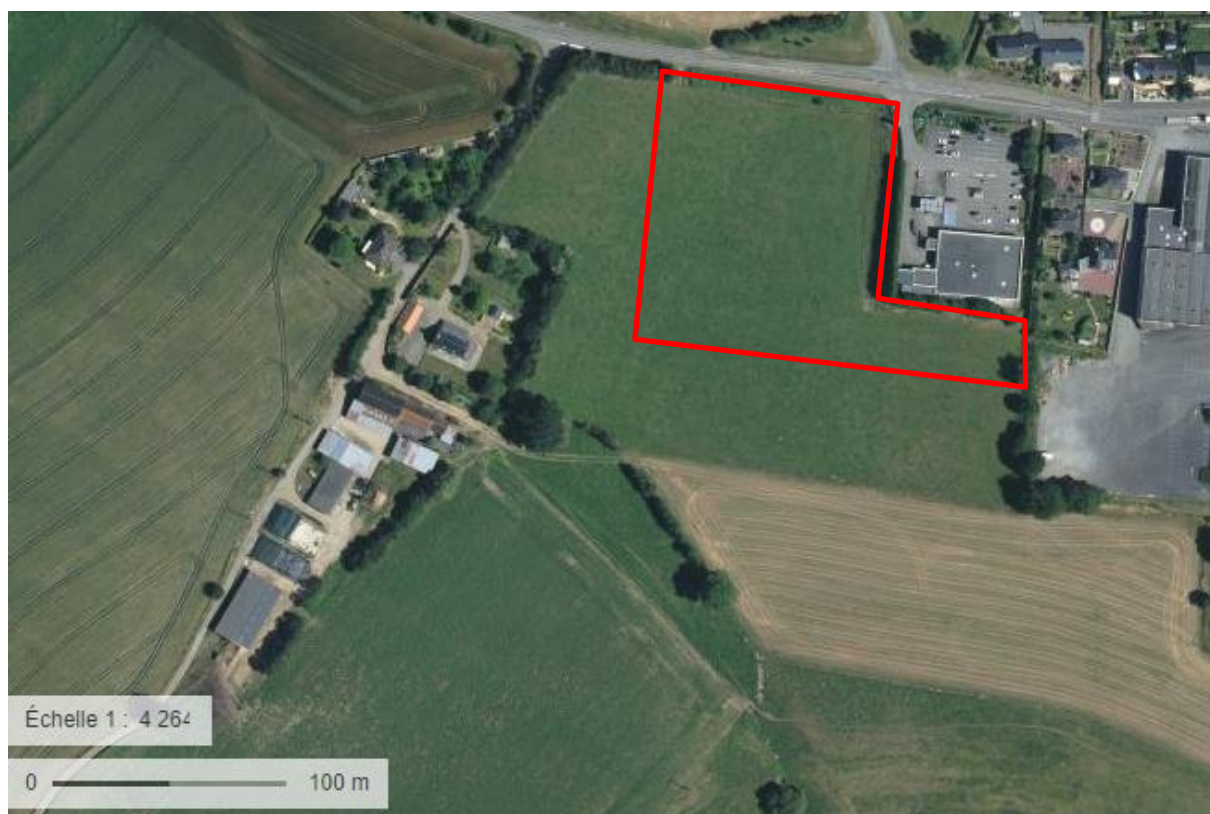
Vue aérienne du site de projet en rouge les espaces concernés actuellement en zone A ; source : Géoportail
