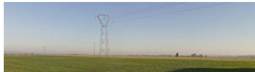
Lignes et pylône impactant le paysage ouvert d'Ambrières-les-Vallées
