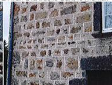
Diverses manières de tirer un fer sur les joints, parfois la découpe devient sophistiquée.
