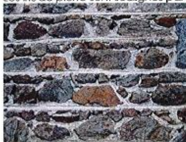
Diverses manières de tirer un fer sur les joints, parfois la découpe devient sophistiquée.
