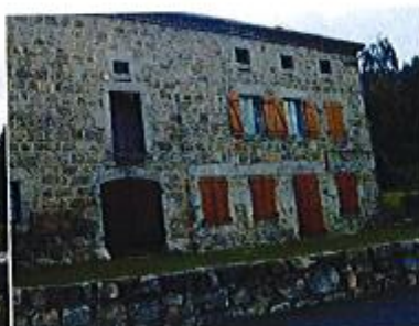
Deux types de volets sur un m me bâtiment
