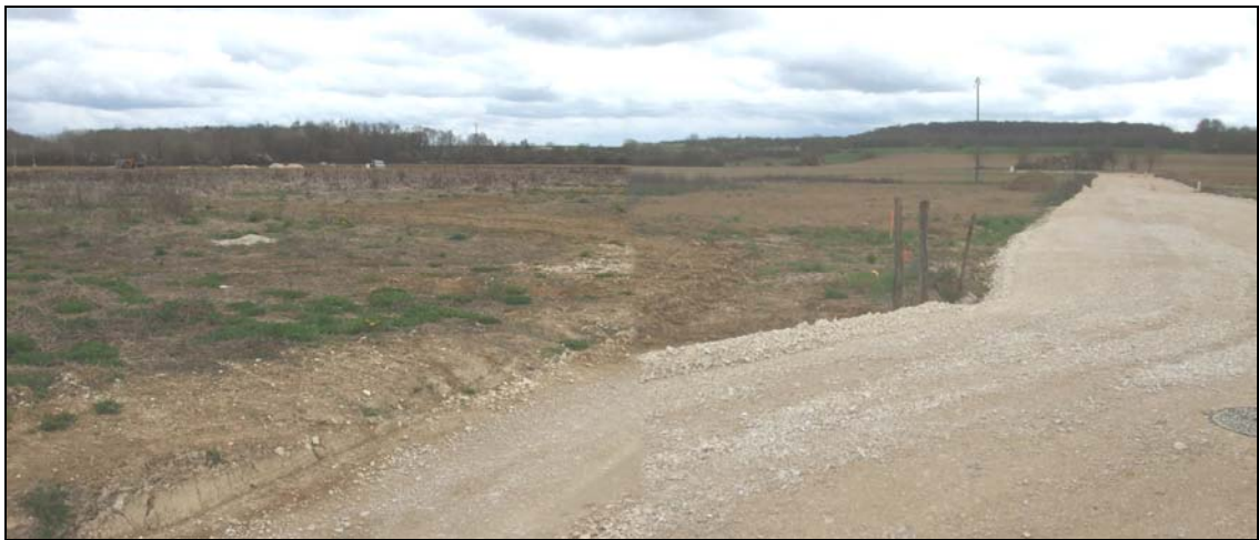
Vue de la zone UY en cours de terrassement.
