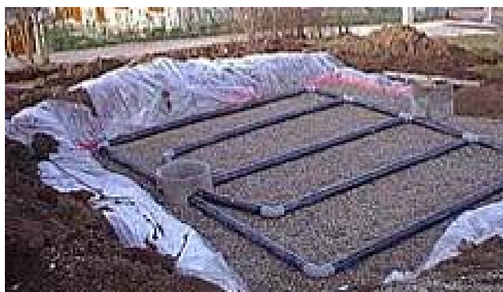
Filtre à sable avant remblaiement
