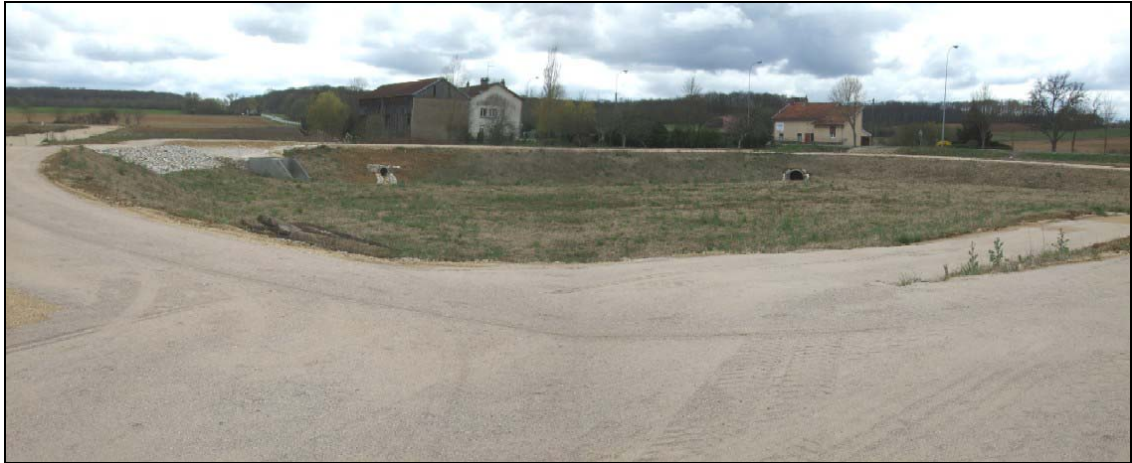
Bassin de rétention des eaux pluviales de la zone UY adjacente.
