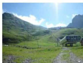
Remontées mécaniques de Barèges
