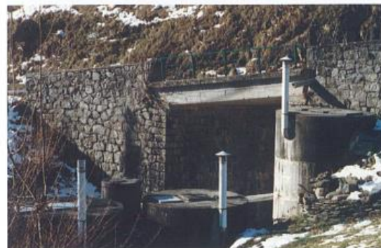
3 Pont maçonné sur le ruisseau Ambat
