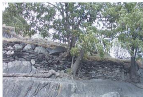
3 Soutènement d'un pré en terrasse (haut du village)
