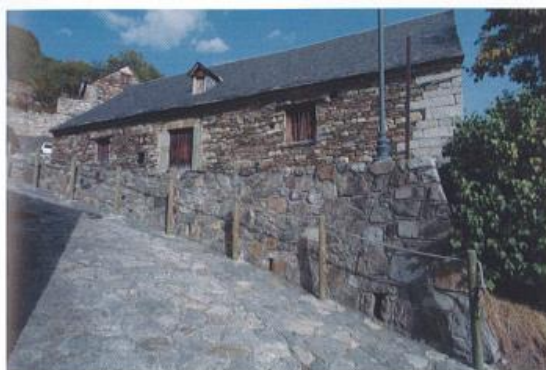
2 Murs de soutènement entre rue et grange (rue Capdevielle)
