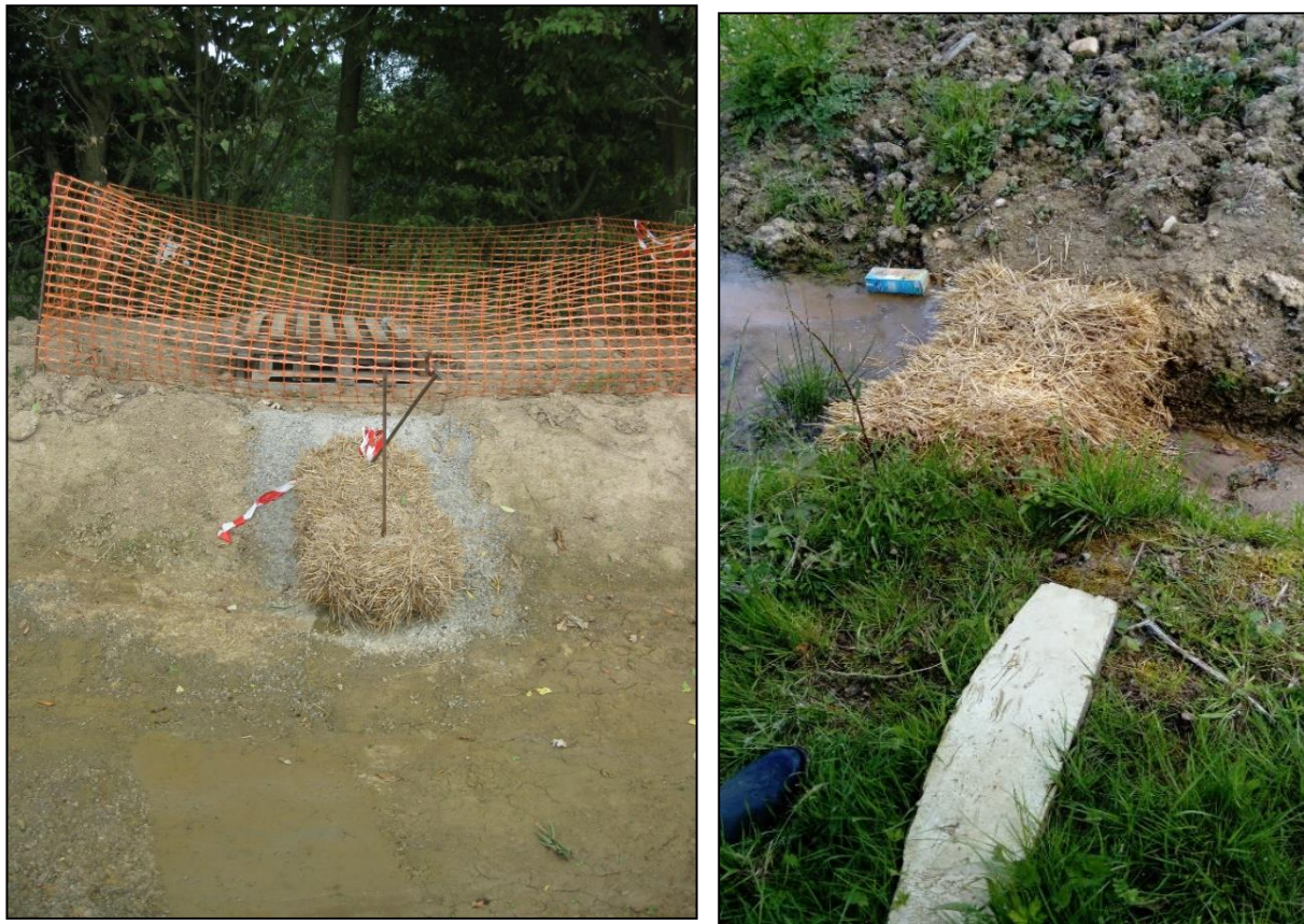
Figure 38 : Emplacements du filtre à particules fines (botte de paille) pendant la phase des travaux au niveau du bassin d'orage
