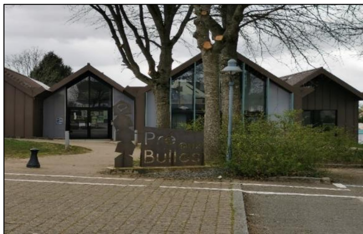
Locaux PRE'AUX BULLES côté médiathèque
