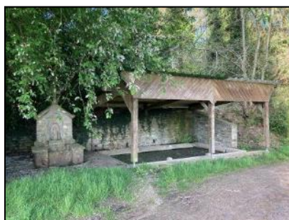
Photographie du lavoir - Coët Bugat.
