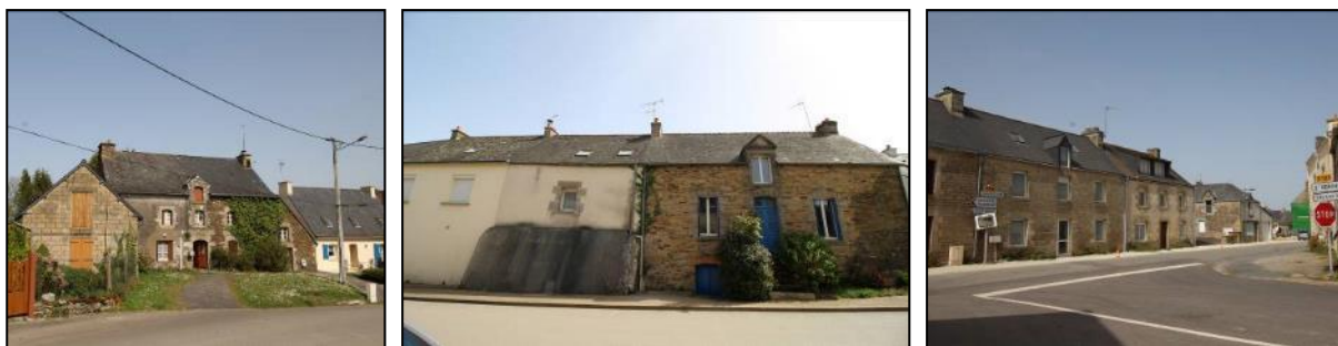
Photographies de bâtisses du centre-bourg.
