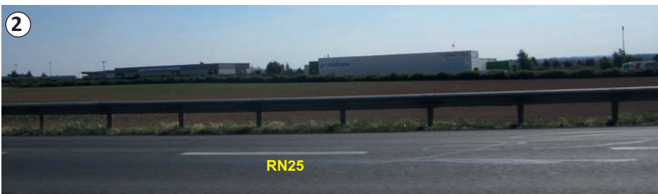
Vue depuis la RN25 à l'est - la végétation basse habille le bas des constructions existantes. Les vues sont majoritairement ouvertes depuis cet axe.
