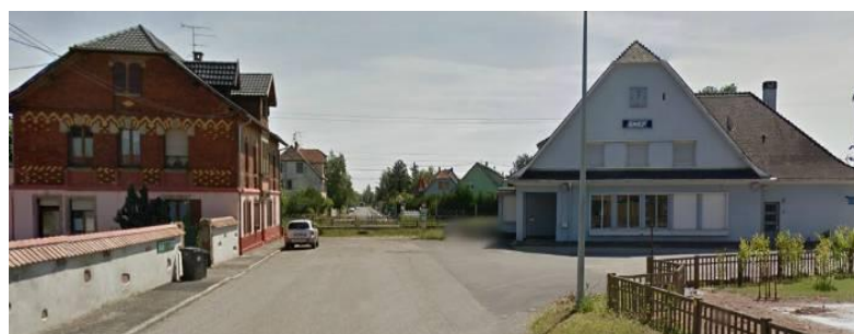
Divers aspects de la zone UE, notamment de ses fonctions résidentielle et ferroviaire.
