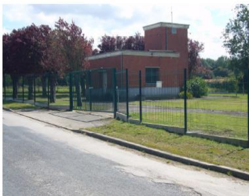
Station de Pompage à Nielles les Ardres
