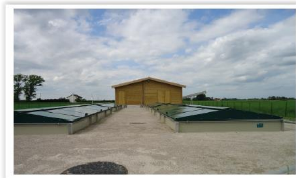
Station d'épuration de Sainte Marie Kerque
