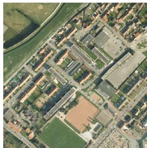
Illustration 56: Zone à grands ensembles d'habitat collectif, Gravelines
