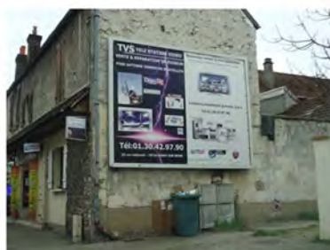
Enseigne sur pignon aveugle de surface importante
