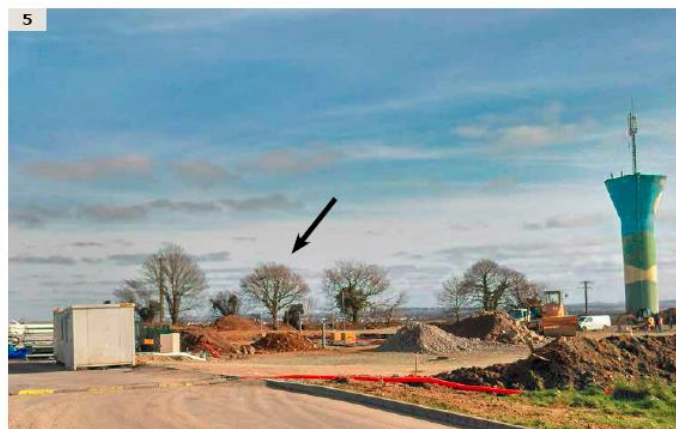
Talus bocager résiduel en coeur de zone, dans le prolongement du château d'eau.
