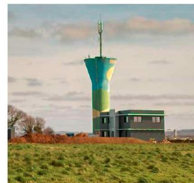
Bâtiment à toit plat construit à proximité du château d'eau qui s'intègre peu dans le paysage.
