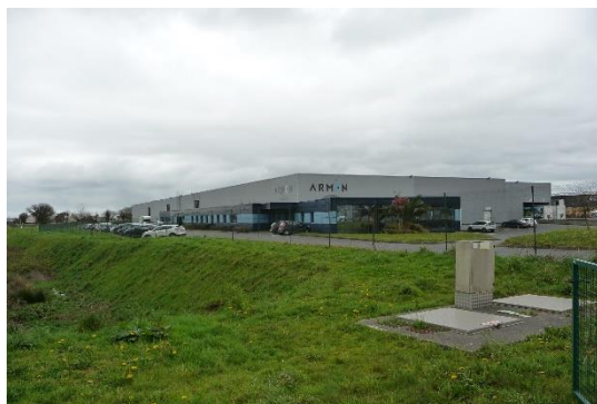
Bâtiment de l'entreprise 'Armen' (gabarit le plus important actuellement)
