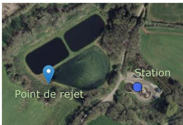
Figure 8 : Photographie aérienne de la station de traitement de Ti Poullin
