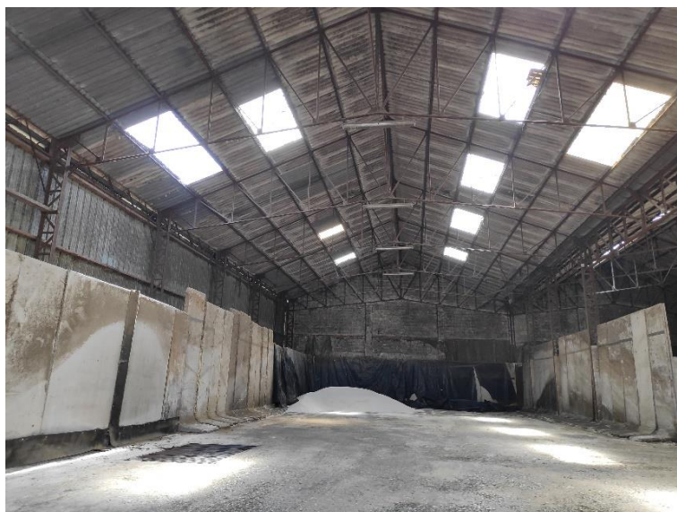
Vue intérieure d'un hangar
