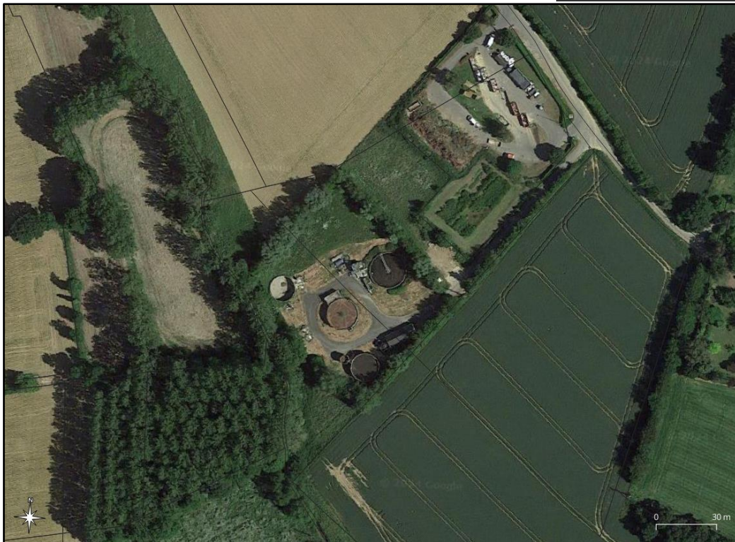
Zoom sur la station de traitement des eaux usées de Melesse
