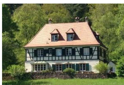
Dambach – Ancienne maison forestière du Fischerackerhof
