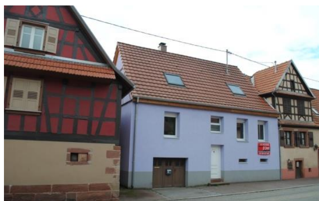
Rothbach – Maison isolée par l'extérieur
