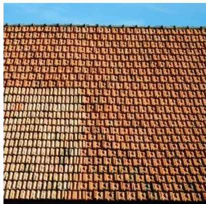
Uttenhoffen – Tuiles mécaniques à losanges
