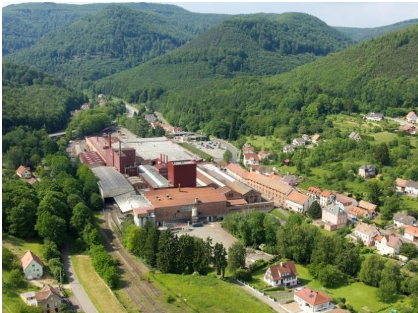
Vue aérienne du quartier autour de la Fonderie à Niederbronn-les-Bains
