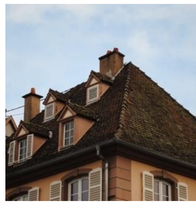
Niederbronn-les-Bains – Toiture à quatre pans
