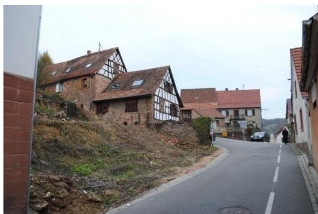
Niederbronn-les-Bains – Dent creuse résultant de la destruction de deux maisons anciennes
