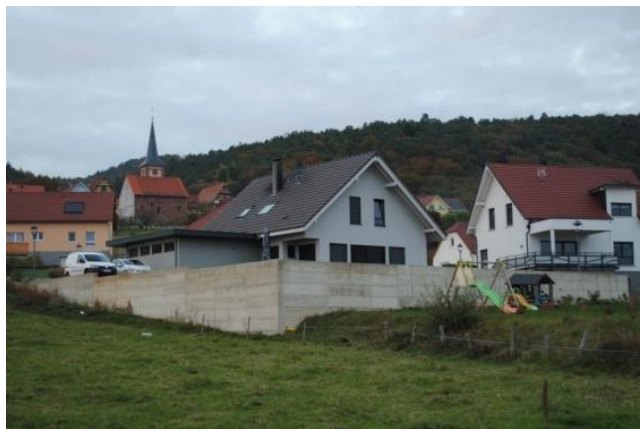
Offwiller – Murs de soutènement, maison conçue pour un terrain plat
