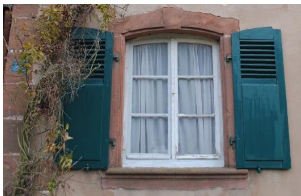
Offwiller – 6 carreaux à petit-bois, volets à persiennes dans le tiers supérieur
