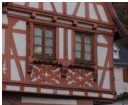
Oberbronn – Encadrements de fenêtres à chambranle saillant mouluré
