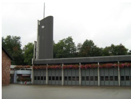
Caserne des pompiers à Niederbronn-les-Bains
