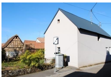
Gundershoffen – couverture en bac acier
