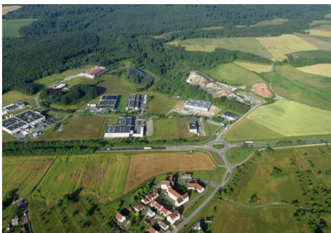
Zone d'activités du Sandholz à Niederbronn-les-Bains
