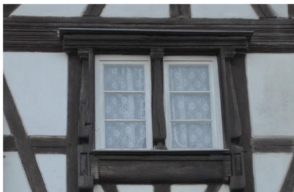
Dambach – Encadrement Renaissance à chambranle saillant mouluré, fenêtre à 3 carreaux
