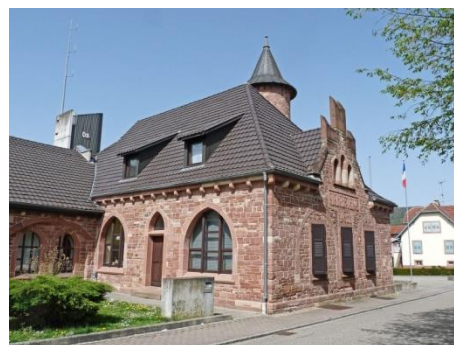
Niederbronn-les-Bains – Ancienne usine d'électricité
