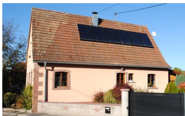
Eberbach (Gundershoffschen) – Panneaux photovoltaïques
