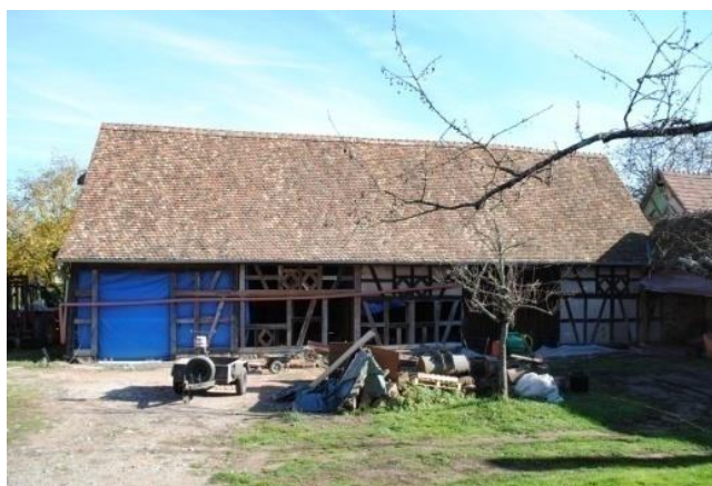
Uttenhoffen – Grange en cours d'aménagement
