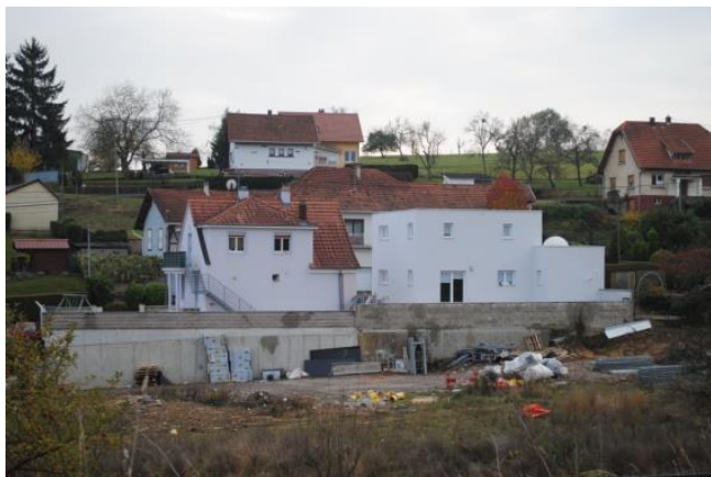
Niederbronn-les-Bains – Murs de soutènement
