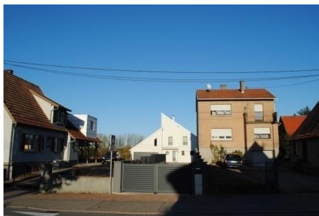
Mertzwiller – Construction en seconde ligne
