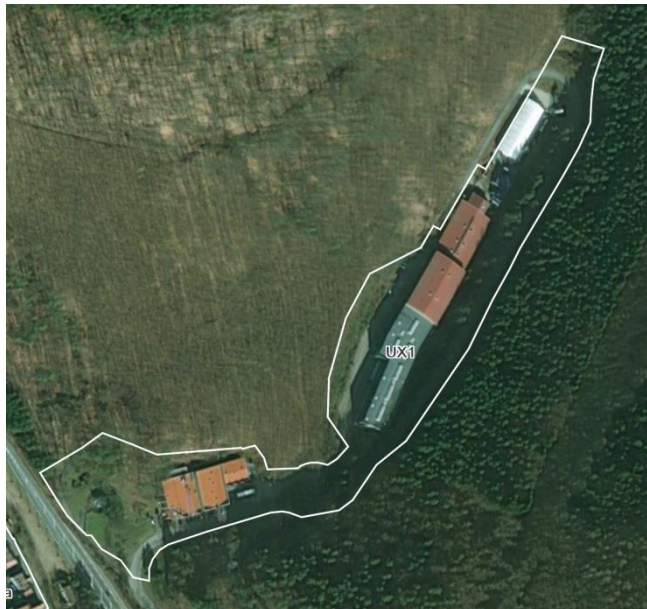
Usine Celtic à Niederbronn-les-Bains
