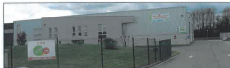
Centre de tri des déchets recyclables d'Étrépagny
