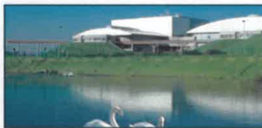
L'usine d'incinération de Guichainville
