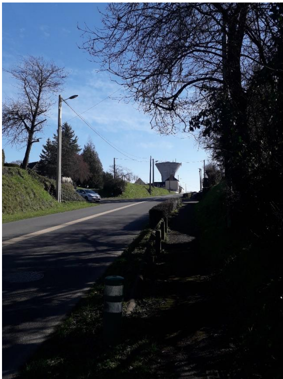
Vue du site sur RD 24 _ sens entrant
