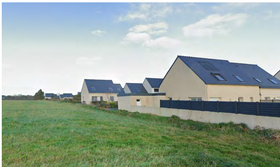
Parcelle ZM 2 (voir ci-dessus) : la réalité du terrain permet de constater une erreur matérielle sur cette parcelle. Aucune haie ou talus existe
