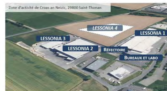
Lessonia1 : bureau / laboratoire / stockage et fabrication d'ingrédients et produits cosmétiques Lessonia 2 + 3 : stockage et conditionnement de produits cosmétiques Lessonia 4 : projet
