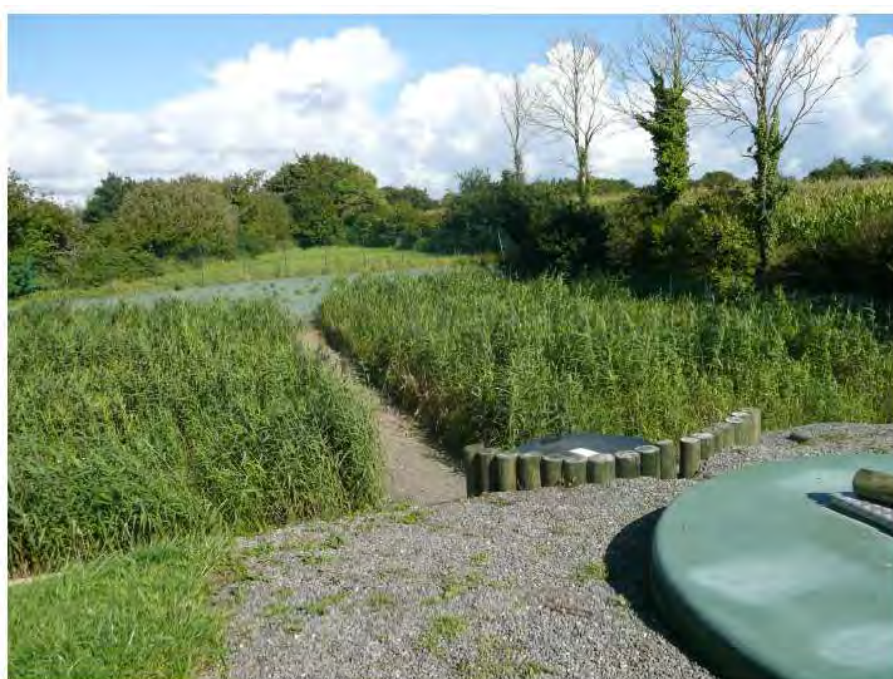
Figure 11 Filtres plantés de roseaux de Rostiviec
